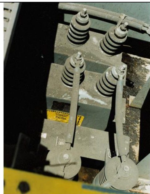
Foto N° 13: Minas de carbón – planta de fuerza con capacitores que contienen PCB
