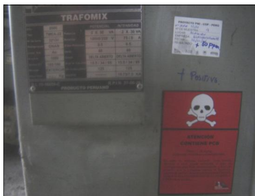
Foto Nº 22: Transformador con PCB etiquetado
